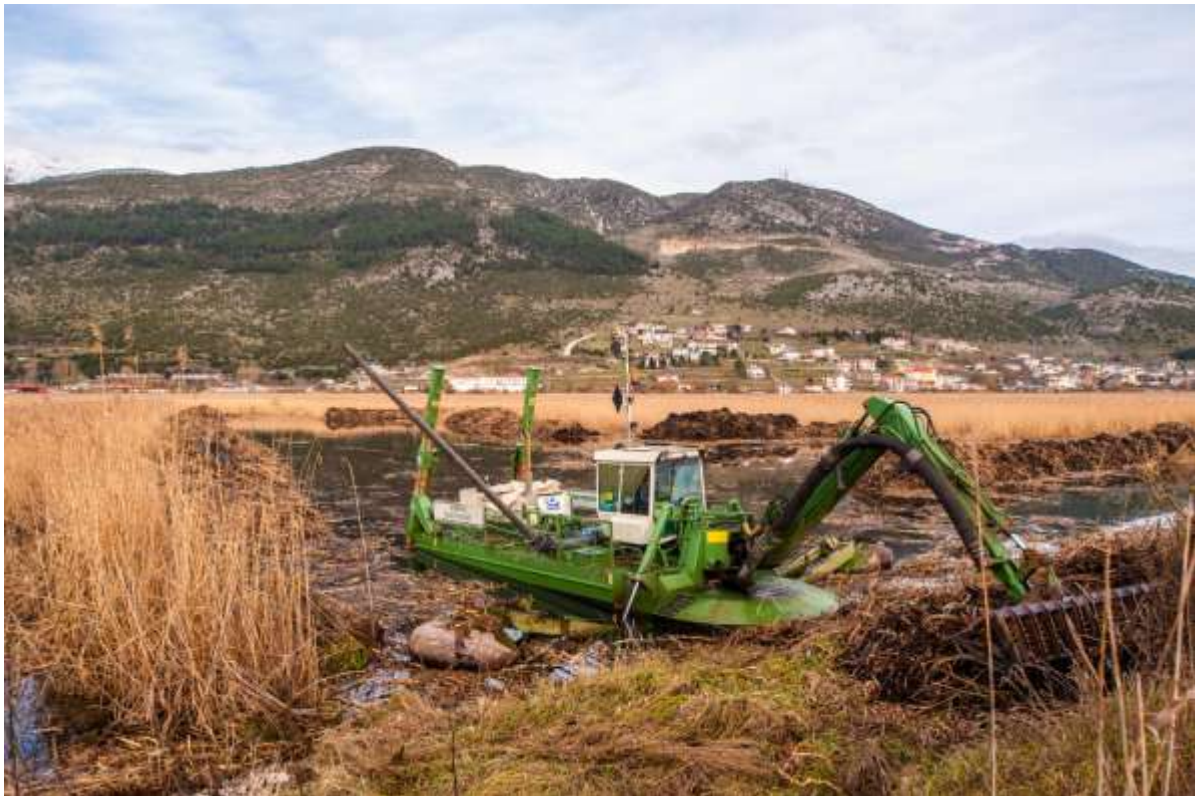
Εικόνα 3. Κοπή, εκρίζωση καλαμών και εκβάθυνση στις 23.01.2013
