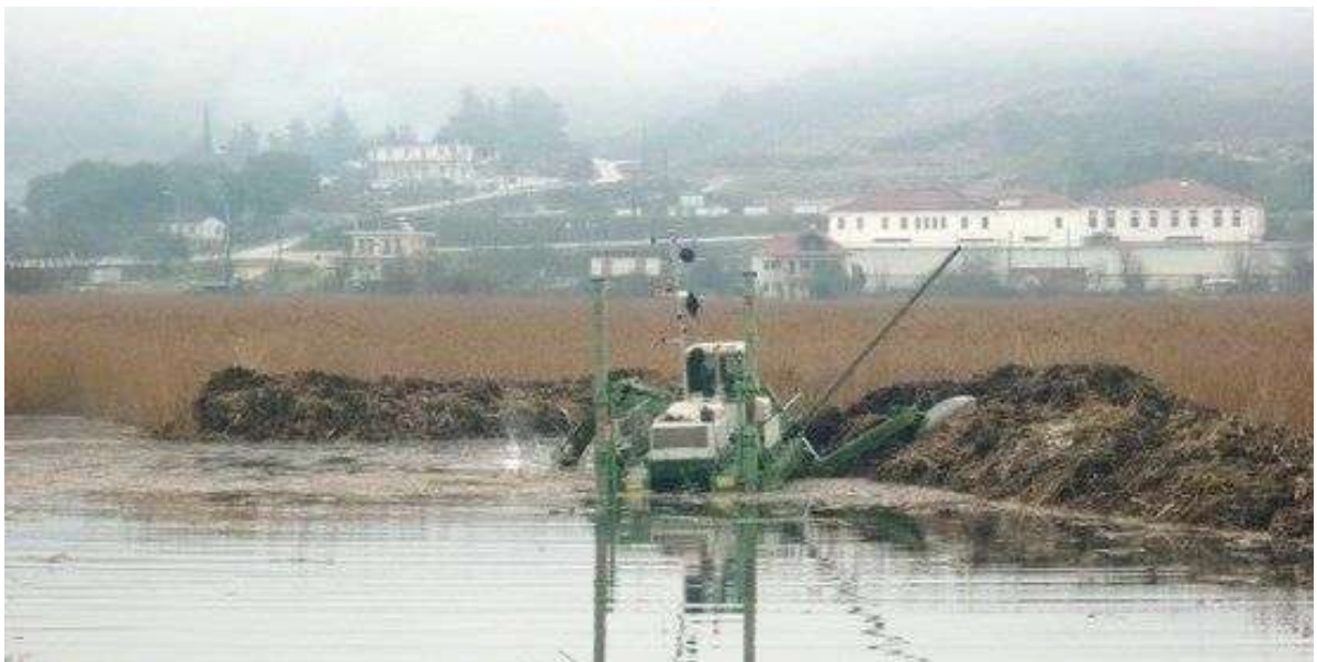
Εικόνα 2. Κοπή, εκρίζωση καλαμώνι και χωματουργικές εργασίες στις 12.01.2013
